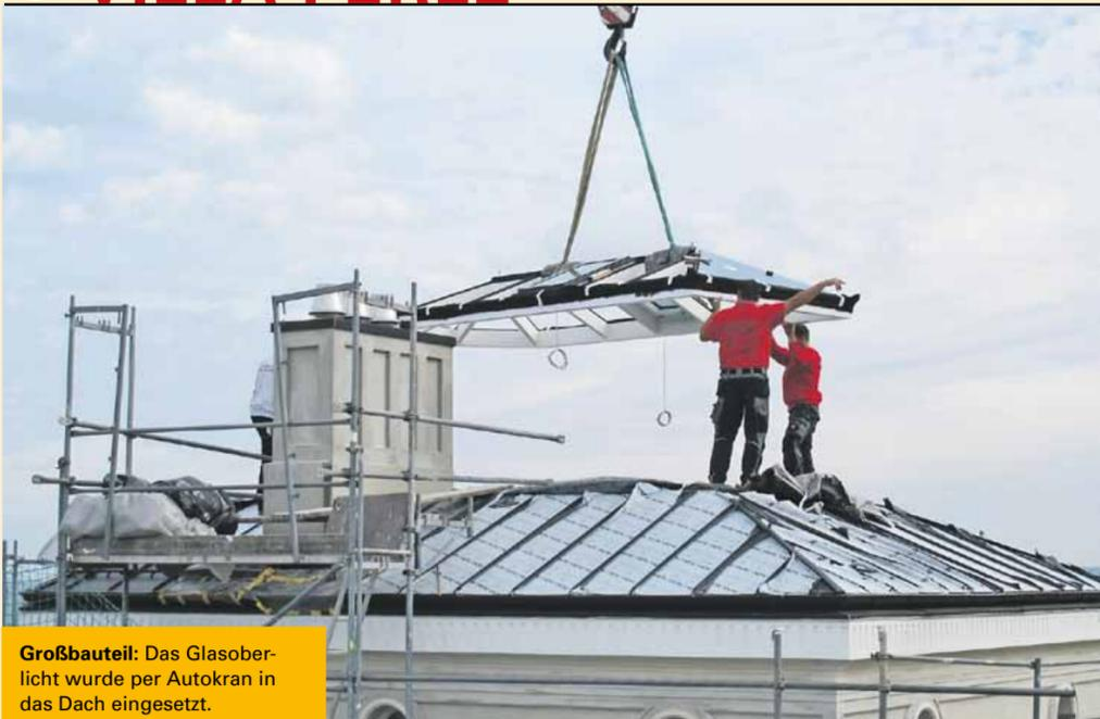
**Großbauteil:** Das Glasoberlicht wurde per Autokran in das Dach eingesetzt.
